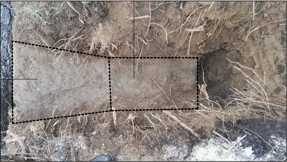
Obr. č.1: Kopaná sonda KS2/44 pro ověření tvaru zárubní zdi.
